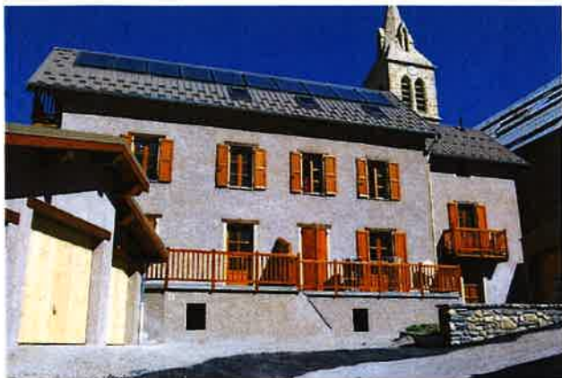
Extérieur du bâtiment
